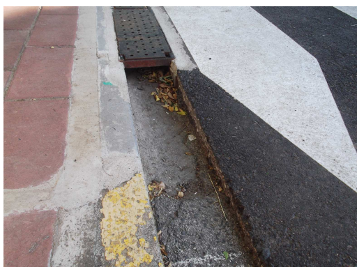
Detalle del paso de peatones elevado.
