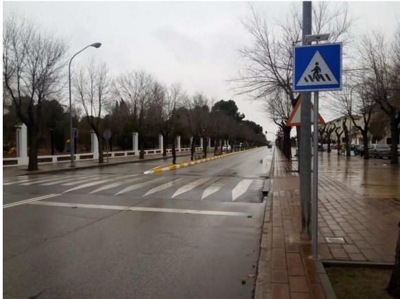
Nueva mediana en la Vía Principal del Polígono Industrial. Objetivo, reducir de la velocidad
